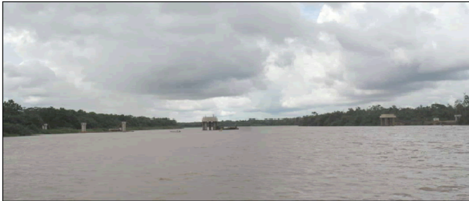
Lado de Goiás – todas as estacas e blocos concretadas
