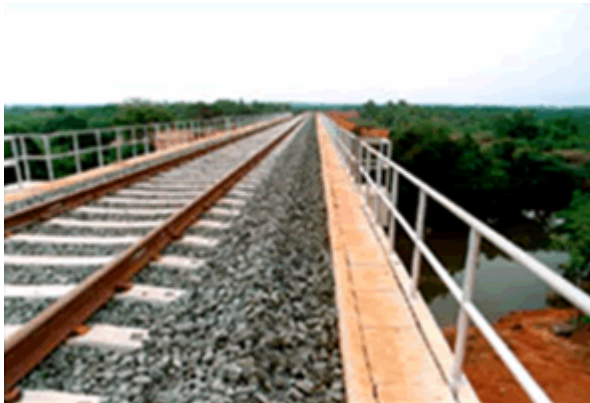
Construção da Ferrovia Norte-Sul
