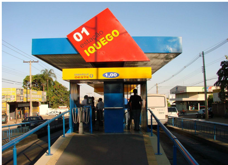
Plataforma 01 Estação IQUEGO reformada
