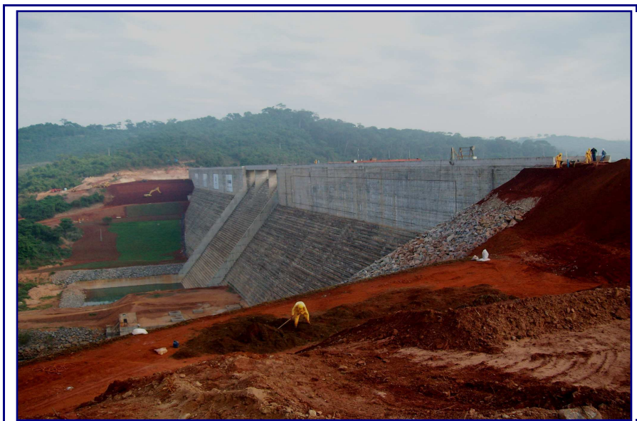
Aterro Compactado - Barragem Ribeirão J. Leite
