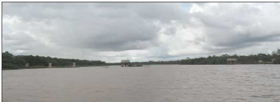
Lado de Goiás – todas as estacas e blocos concretadas
