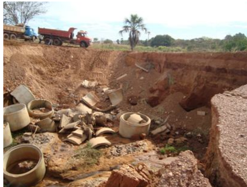
Execução de obras emergenciais para recuperação de barragem de captação de água no Distrito Agroindustrial de Aparecida de Goiânia – DAIAG. Processo n.º 185.08/10
